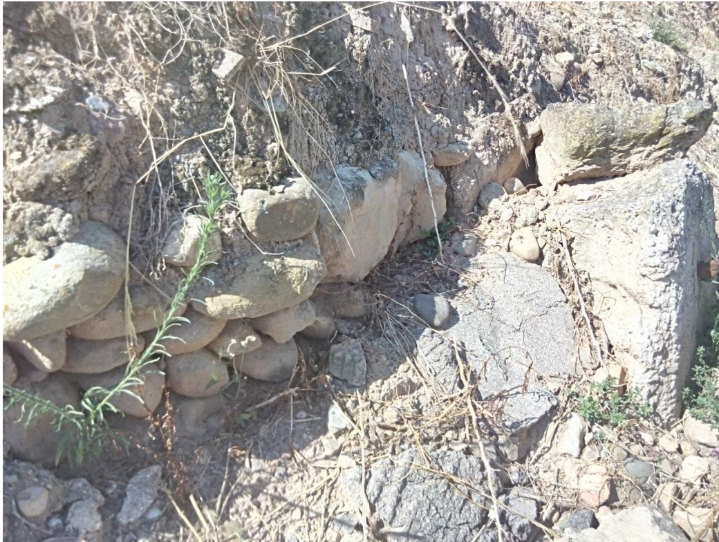
Idem, anterior. En la última se aprecian restos de asfalto y zapatas de hormigón del antiguo vallado.
