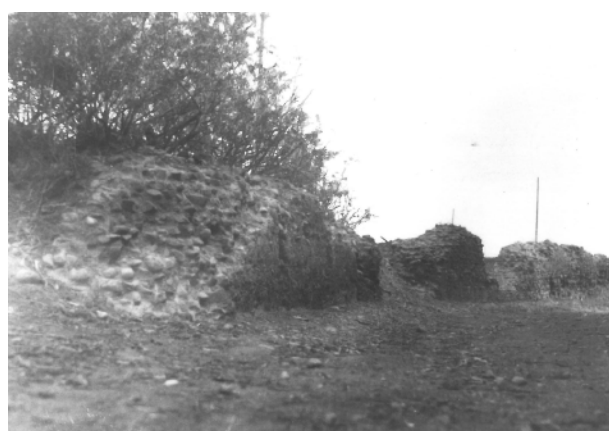
Figura 4. Muro correspondiente a la fachada norte hacia los años 20 del pasado siglo, actual calle Paletillas (Archivo Bella).
