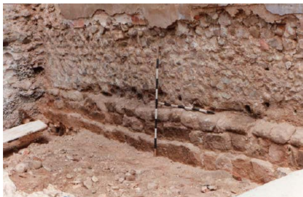
Figura 2. Estructura del podio en el lado sur, Mercadal 30-36. Fotografía: Pilar Pascual Mayoral.
