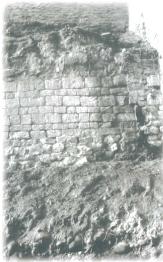
Foto 9 - El mismo desagüe después de la restauración.
