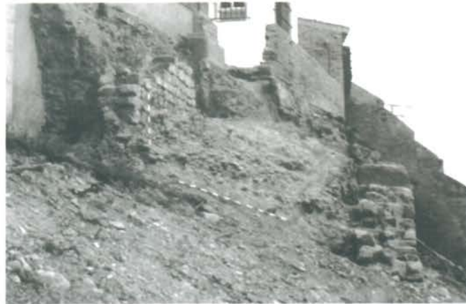
Foto 5 -Corte del Lienzo I en el que se aprecian los dos paramentos que forman la muralla.
