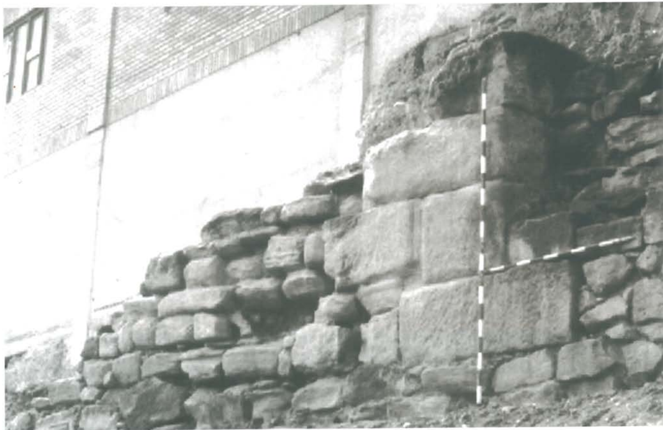
Foto 4 -Detalle del Lienzo I en el que se aprecia uno de los muros transversales de la muralla.
